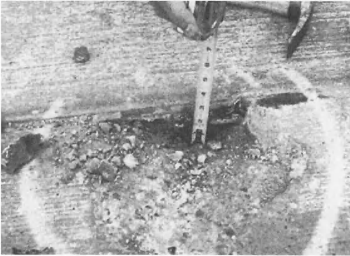
.Figure 19-53 (d) Excavation at precast double tee flange connector.
